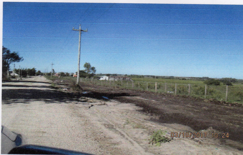
Calle 60 (ingreso vehículos de carga): ensanche y sustrato en proceso
